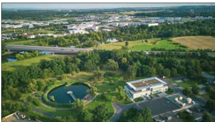
Abb. 2: Eingebettet im Grünen, dennoch zentral gelegen ist das neue Kläranlagengelände der Stadtentwässerung Schweinfurt.
