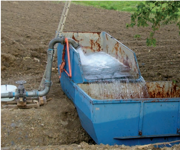
Abb. 5 Spülen der Leitung am Tiefpunkt (Brunnenalter > 30 Jahre)
