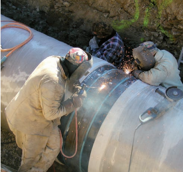
Abb. 3 Schweißen einer Stahlrohrleitung DN 1.200
