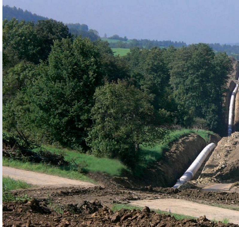
△ Abb. 1 Die Anlagen der Landeswasserversorgung ▷ Abb. 2 Stahlrohrleitung DN 1000 in schwierigem Gelände
