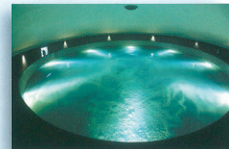
Fassungsbauwerk der Buchbrunnenquelle im Egawasserwerk
