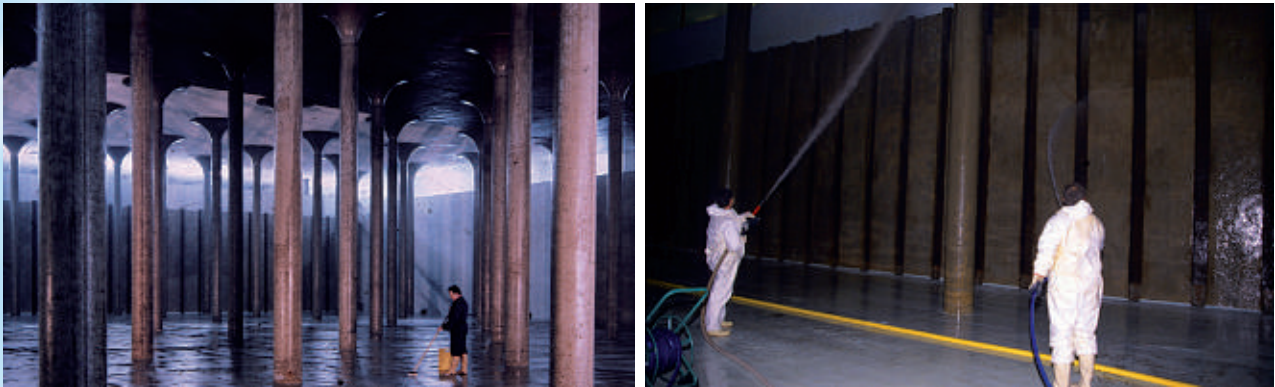
Bilder 4 + 5: Behälterreinigung mit Trinkwasser
