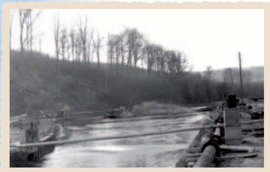
Bild 3 Vor dem Baubeginn wird der Quelltopf entschlammt.
