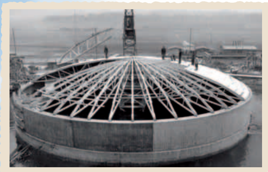
Bild 6 Schalungsarbeiten für die frei tragende Kuppelschale
