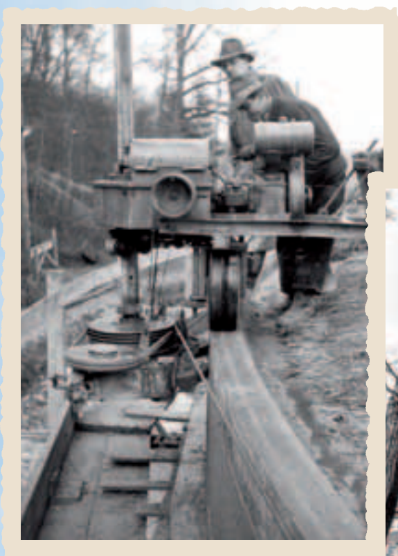
Bild 7 Einbau der Ringbewehrung zur Aufnahme der Dachlasten
