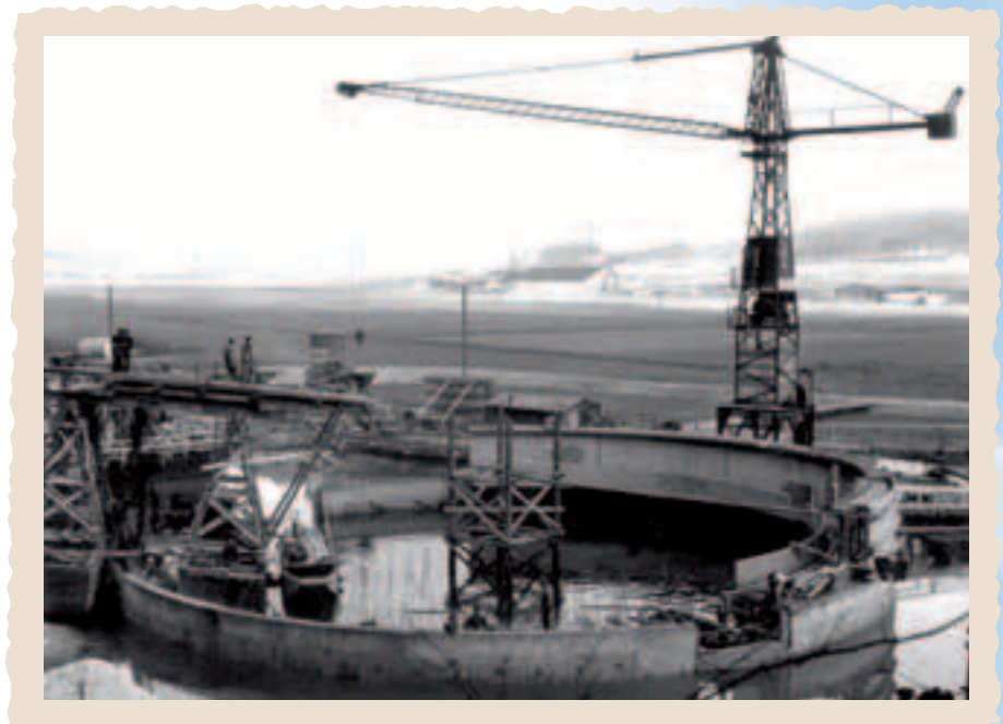
Bild 5 Im November 1954 sind die Betonarbeiten am Fassungsbauwerk bereits weit fortgeschritten.
