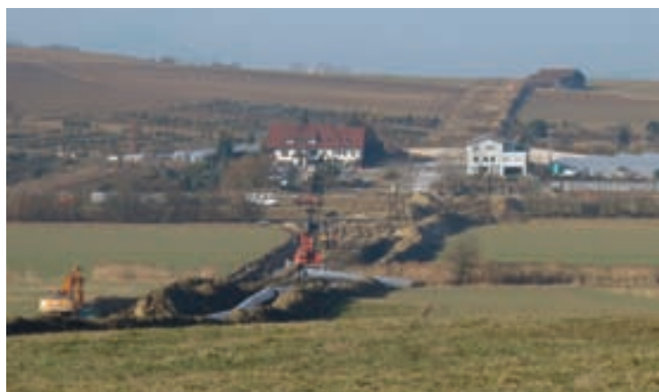
Bild 3 Baustelle Heubach-Lautern 2008 (Baumschule)
