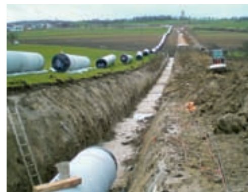
Bild 2 Neue Trasse (Ein-Rohr DN 1200) bei Wäschenbeuren (2007)
