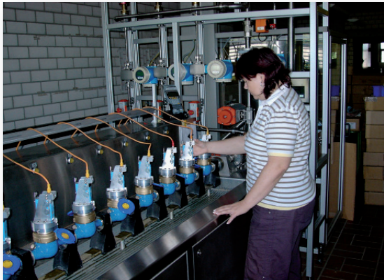
Die Prüfung der Hauswasserzähler erfolgt auf einem modernen elektronischen Prüfstand
